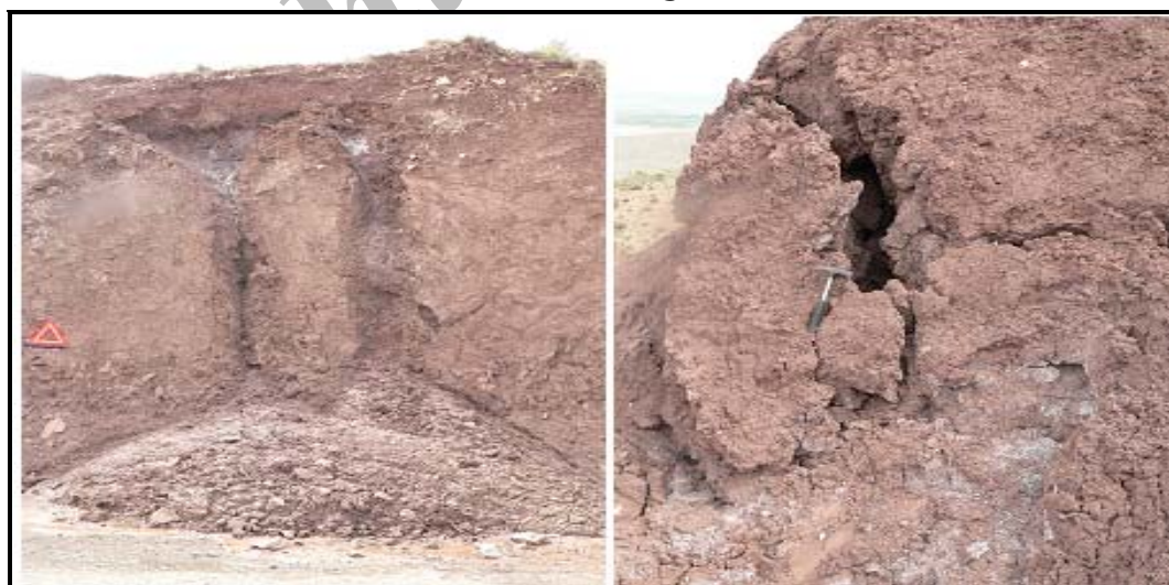
شکل شماره ۸ مارن‌های مسیر راه ارلان و عمل آب‌های سطحی و زیر زمینی بر روی آن
