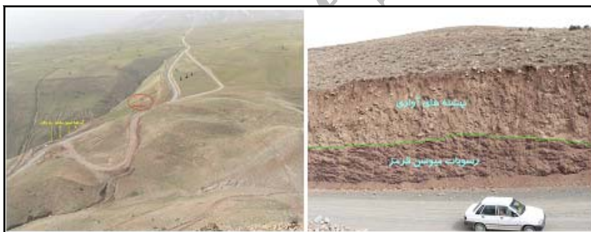
شکل شماره ۱۱ (راست) ترانشه ایجاد شده و چگونگی استقرار نهشته‌های آواری بر روی رسوبات میوسن قرمز، چپ) جابه‌جایی مسیر راه به طرف آبراهه عمیق مجاور راه با دامنه‌هایی ناپایدار
