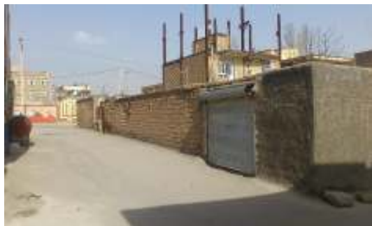
شکل ۲۹- عناصر چشم‌آزار و ساختمان‌های در حال ساخت بدون پوشش مناسب (بهارستان پایین، ۱۳۹۳)
