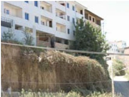
تصویر ۵ خانه سازی روی تپه های لسی در شهرک صدا و سیما
