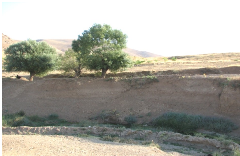
شکل ۹: فرسایش کناری رودخانه سنقرچای در پایین دست بند
