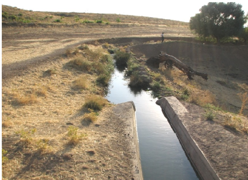
شکل ۱۰: کانال مصنوعی انحراف آب در طرفین بند سه آسیاب
