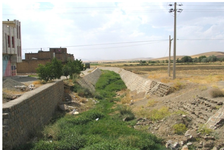
شکل ۵: کانال مصنوعی جهت انحراف آب‌های زیر حوضه شمالی
