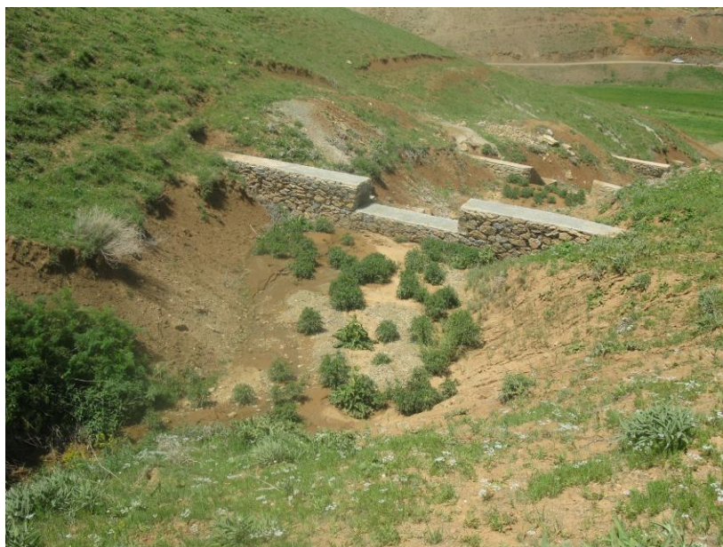
شکل ۲: نمونه‌ای از سازه‌های اجرا شده در حوضه گاودره
