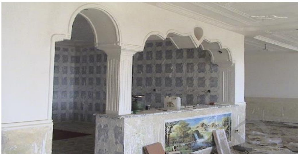
شکل ۹: ساخت آشپزخانه اوپن، مسکن در حال ساخت، محمدآباد
