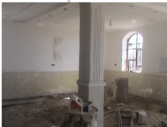
شکل ۸: گچ کاری و سنگ‌کاری نمای داخلی خانه
