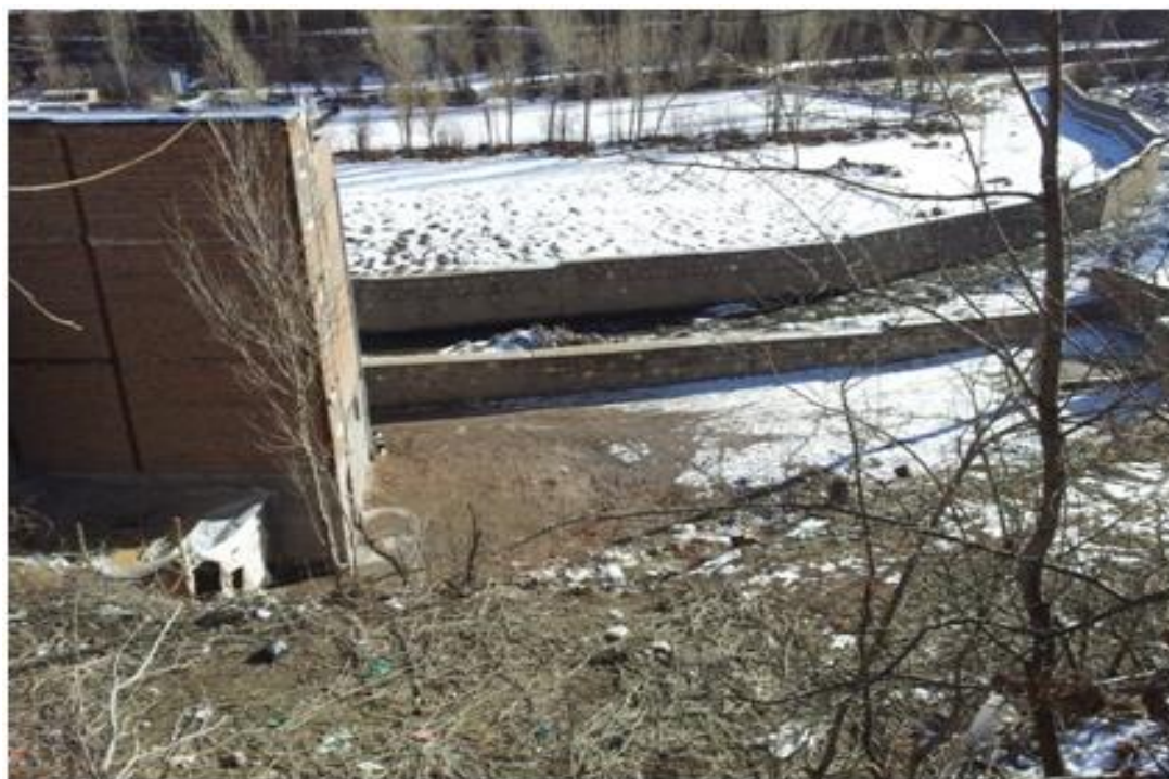
شکل ۷: تجاوز به حریم رودخانه و کانالیزه کردن مجرای رودخانه در مقطع شماره ۸
