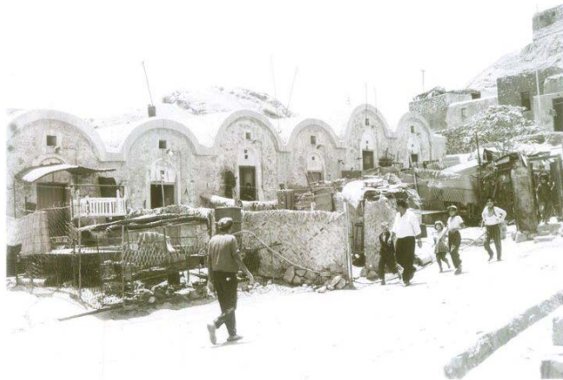
شکل ۳. خانه‌های کارگری در مسجدسلیمان
