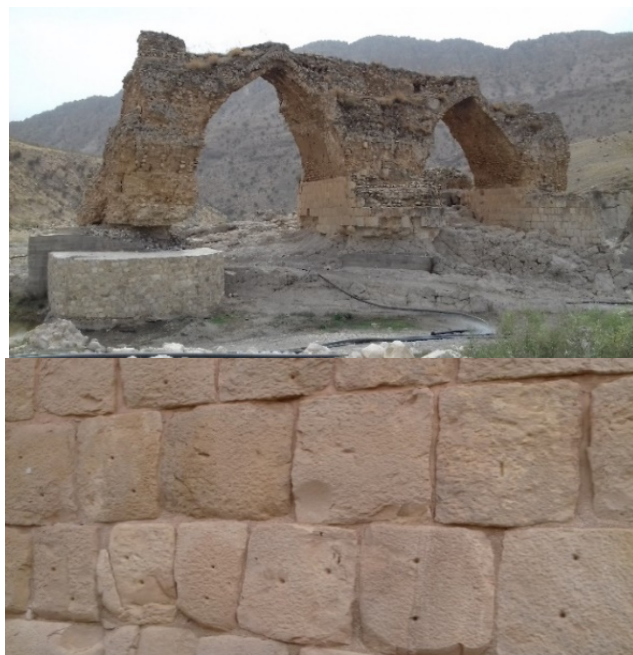
تصویر ۱۰: نمایی از پل سی‌پله و علایم حجاران که بر روی قطعات سنگ در پایه‌های پل به کار رفته است. مأخذ: نگارندگان
