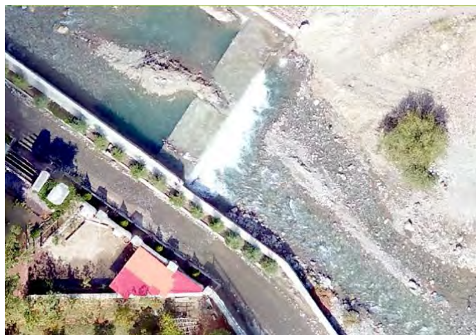
شکل (۱۰). ایجاد بستر مصنوعی و پیدایش تندآب و همچنین وجود موانع طولی متعدد در درون کانال در بازه ۴
