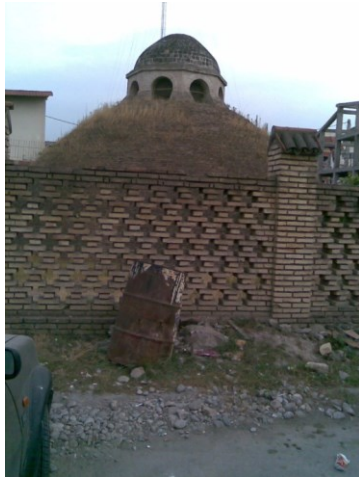
شکل (۷). آب انبار در محله آب انبار نو
