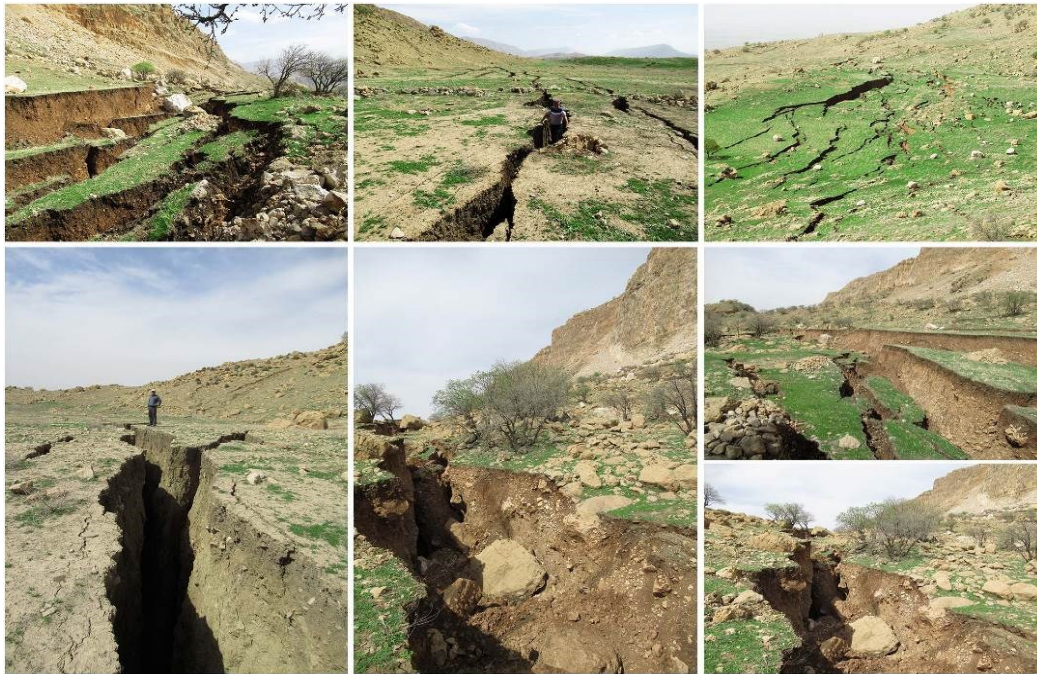
شکل (۸). الگوی توزیع و شکل شکاف‌ها ناشی از زمین لرزه بر روی زمین لغزش مله کبود بیانگر لغزش چرخشی آن است.
