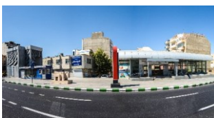
شکل (۸). ناهماهنگی بدنه ایستگاه مترو
