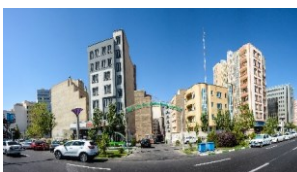
شکل (۷). ناهماهنگی مصالح ساختمان‌ها
