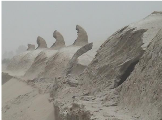
شکل ۱۵: سایش سقف مسکن بومی توسط ماسه‌ها
