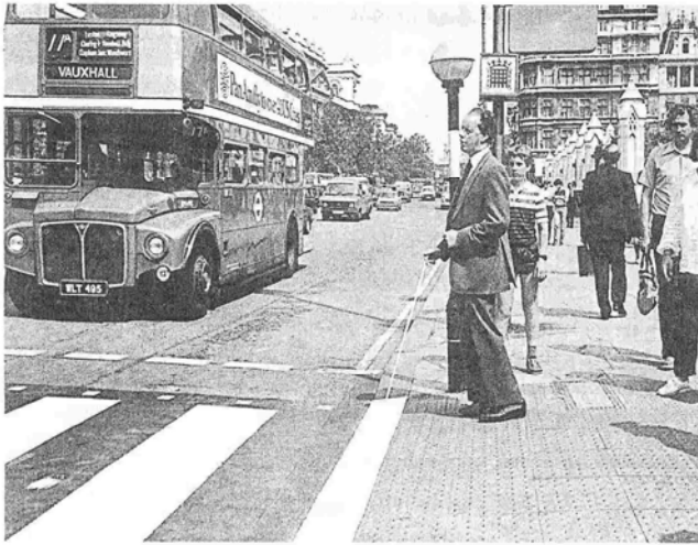
تصویر (۲) تعبیه سطوح برجسته در پیاده رو به منظور یاری رساندن به افراد نابینا (موسسه بزرگراههای لندن، ۱۹۹۸).
