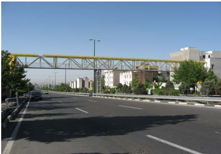
شکل (۴) پل شماره ۴ (تهران- بلوار سردار جنگل)
