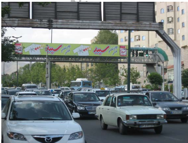
شکل (۵) پل شماره ۵ (تهران- چهارراه باغ فیض)
