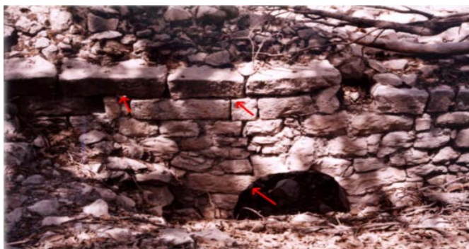
تصویر ۶. ساختمان نیمه‌مدفون و شیوه اجرای قوس
