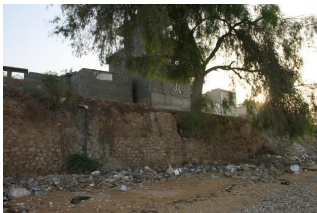
تصویر ۹- بخش‌هایی از دیواره ساحلی و چیدمان سنگ‌هایی هندسی در لایه بیرونی آن با ملاط ساروج (تصویر از نگارنده)
