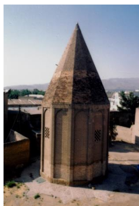
(تصویر ۳) موقعیت بنا پس از تخریب ساختمان‌های مجاور
