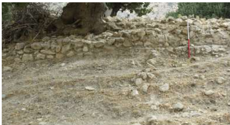
تصویر ۳: پی گچ و سنگی یک دیوار، زیز (عکس از رجبی، ۱۳۹۴).
