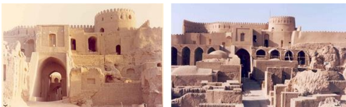
شکل ۴: دو نما از جبهه‌ی درونی دروازه‌ی اصلی در پیش از زلزله‌ی سال ۸۲ خورشیدی، الف. نمایی عمومی دو جبهه‌ی غربی و شرقی و رواق‌های بازسازی‌شده، ب. نمای جبهه‌ی غربی، پیش از مرمت رواق‌ها (مأخذ: بایگانی پایگاه میراث جهانی بم و منظر فرهنگی آن).
