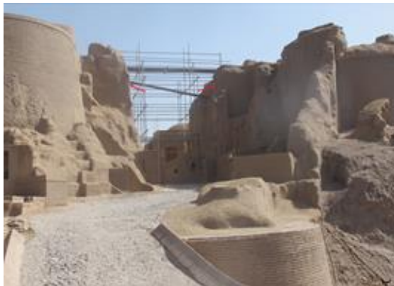
شکل ۶: بقایای برج‌های مکعب هسته‌ی نخستین ورودی؛ الف. نمای ورودی و موقعیت برج‌های مکعبی، بلافاصله پس از زلزله‌ی سال ۸۲ خورشیدی. ب. نمای ورودی پس از تخلیه آوارها، دید از جنوب (مأخذ: بایگانی پایگاه میراث جهانی بم و منظر فرهنگی آن).
