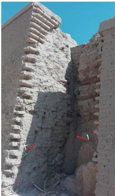
شکل ۷: نمایی از پوسته‌ی مکعب باقیمانده‌ی برج غربی ورودی؛ ۱. لایه‌ی درونی و هسته‌ی اولیه، سلوکی یا اشکانی و ۲. لایه‌ی دوم، بخشی از الحاقات دوره‌ی سلجوقی (مأخذ: نگارندگان).
