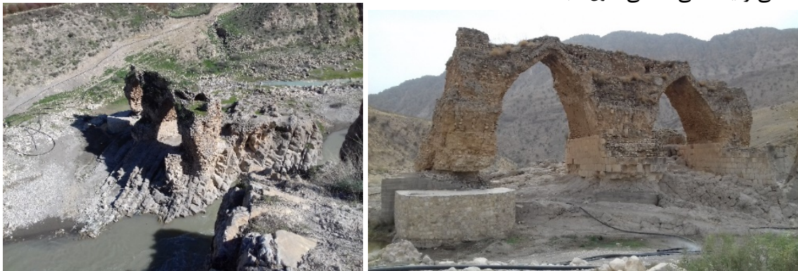
تصویر ۱۲. پل سی‌پله. (تصویر از نگارندگان). Figure 12. Si'pelah bridge (by the authors).
