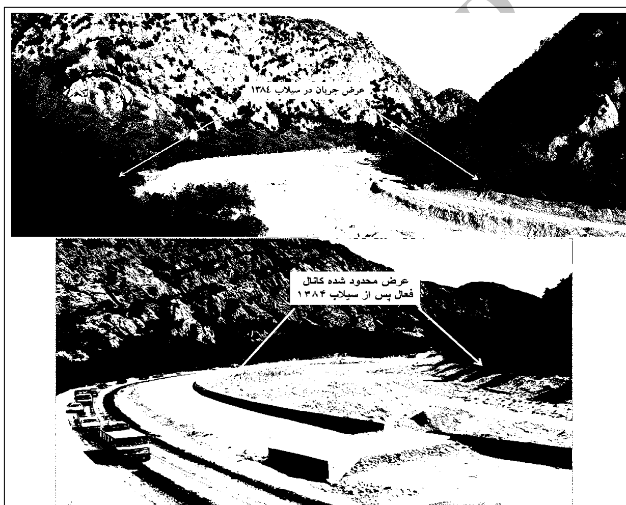
شکل شماره 14- مقایسه عرض بستر فعال سیلاب 1380 و فشار جاده جدید بر بستر فعال
