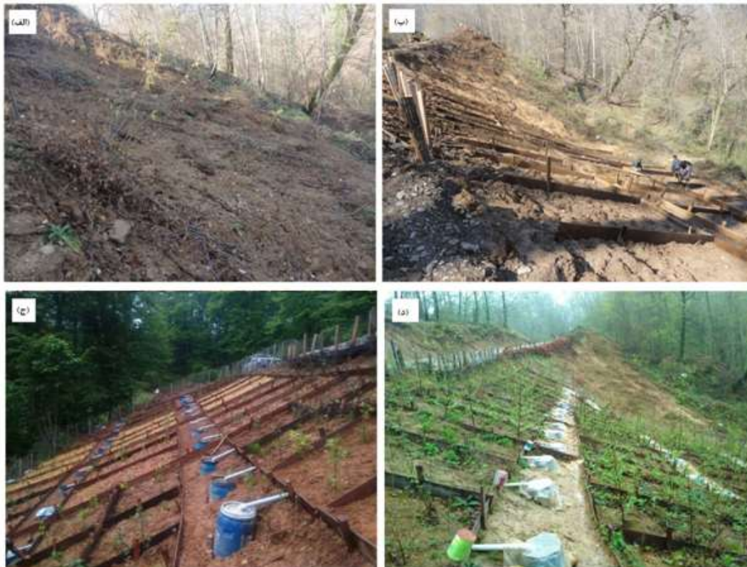
شکل ۴: نمایی کلی از روند اجرای کار در منطقه‌ی مورد مطالعه. الف: سطح شیب‌دار در دامنه‌ی خاک‌ریزی پیش از اعمال تیمار، ب: آماده‌سازی بستر و کرت‌بندی برای اعمال تیمارهای حفاظتی و کاشت نهال، ج: نصب لوله‌ها و بشکه‌های جمع‌آوری رواناب و رسوب، د: نمایی از منطقه در انتهای دوره‌ی مورد مطالعه
