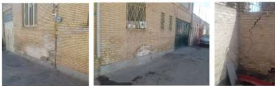
شکل ۹- نمونه‌هایی از تأثیر بالا آمدگی زمین بر ساختمان‌های شهری
