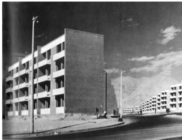
تصویر ۱۳: منطقه آپارتمانی کن (منبع: نشریه سازمان مسکن: ۱۲)
