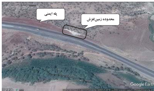
تصویر ۴: عکس هوایی سال ۲۰۱۳ از منطقه‌ی زمین لغزش
