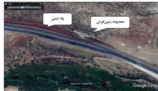
تصویر ۳: عکس هوایی سال ۲۰۱۱ از منطقه‌ی زمین لغزش
