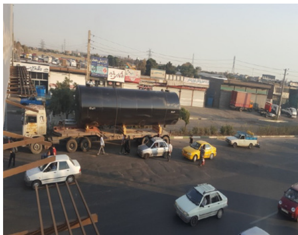
تصویر ۱۱: نمایی از مراحل حمل و نصب مخزن فولادی با حجم ۱۰۰ متر مکعبی در پارک شهر تهران
