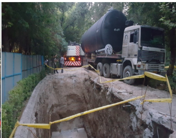
تصویر ۱۱: نمایی از مراحل حمل و نصب مخزن فولادی با حجم ۱۰۰ متر مکعبی در پارک شهر تهران
