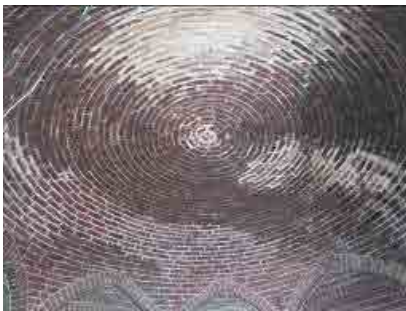
▲ تصویر ۷. گنبد عرقچین پوشش هشتی (نگارندگان، ۱۳۹۳).
