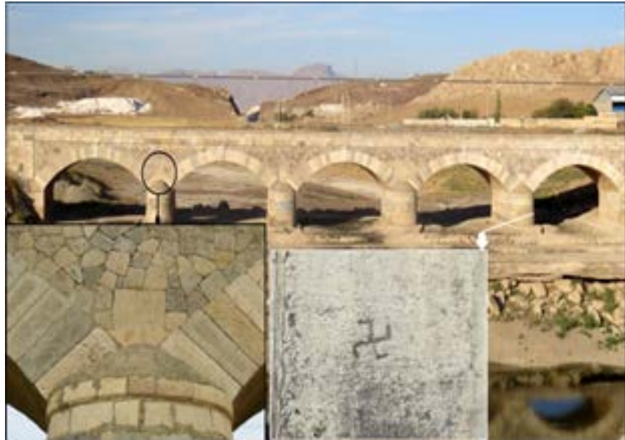
► تصویر ۱۱. پل چهار، سنگ‌های تراش‌دار، علائم حجار و سنگ قبور (نگارندگان، ۱۳۹۴).
