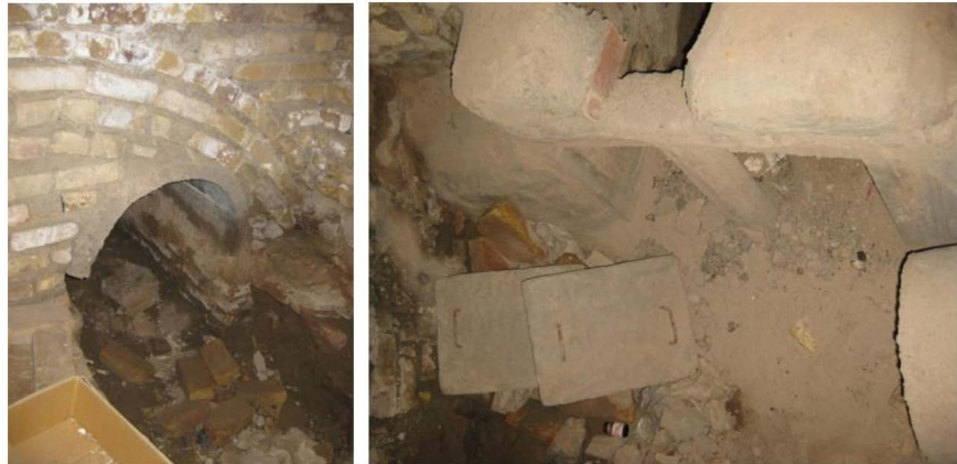
► تصویر ۴. تغار (محل تقسیم آب) در مظهر قنات دولت‌آباد درون محله‌ی آبشاهی (نگارندگان، ۱۳۹۵).
