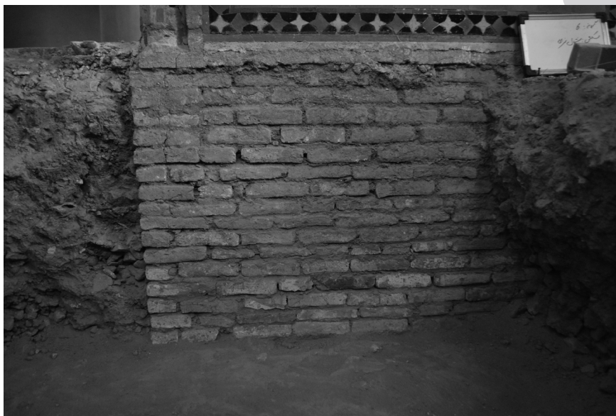
تصویر ۷. کرسی ایجاد شده برای ساخت مسجد (کاظم‌نژند و میردهقان، ۱۳۹۲: ۲۴۳).
