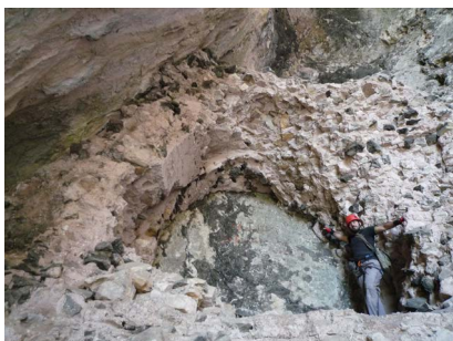
▲ تصویر ۱۴. تاق مازه‌دار تند در غار-دژ اسپهبدان مشابه با قوس درگاه طاق کسرا (توفیق، ۱۳۹۵).
