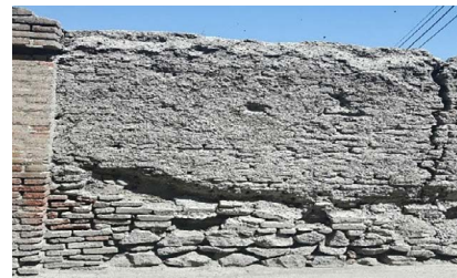
▲ شکل ۵. مصالح خشت همراه با سنگ و آجر در خانه صدر (نگارندگان، ۱۳۹۸).
