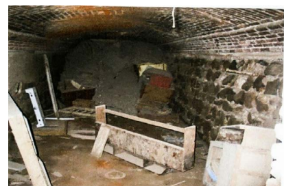
▲ شکل ۷. سنگ در دیوار چینی و سقف قوسی آجری در زیرزمین (نگارندگان، ۱۳۹۸).
