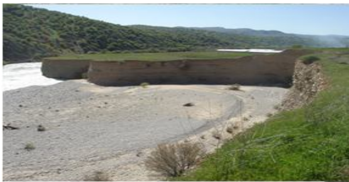
شکل ۷: فرسایش کناری در نتیجه سست بودن رسوب
