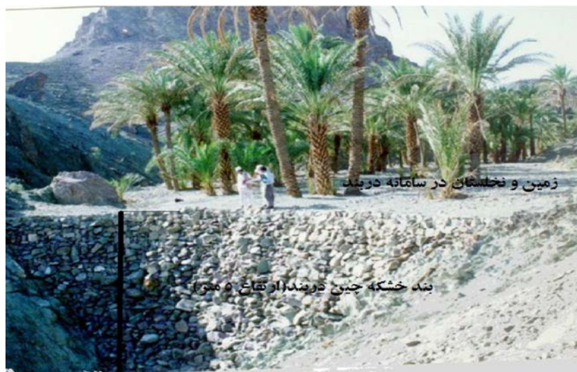
عکس ۲- نمونه‌ای از سامانه دربند در مناطق کوهستانی بلوچستان (آبادی مهند چانف) با درختان نخل چند ده‌ساله
