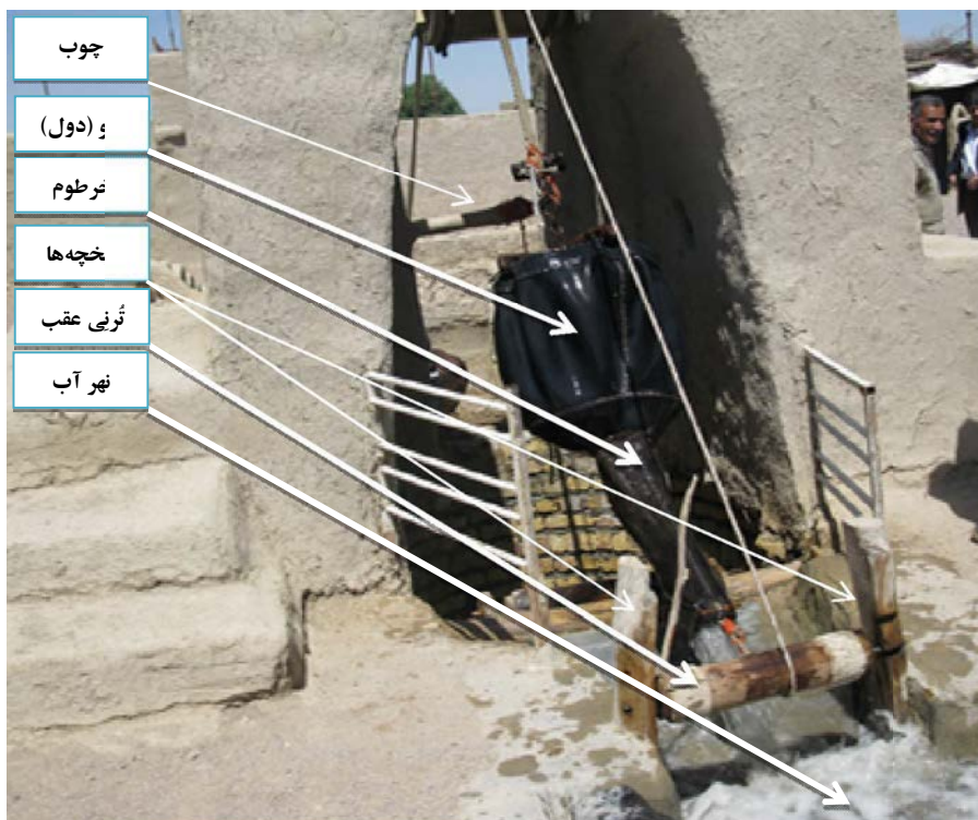
عکس ۷- اجزا و عناصر سحیل‌دهنده داوچاه در داوچاه حاج ابراهیم (رورنه)
