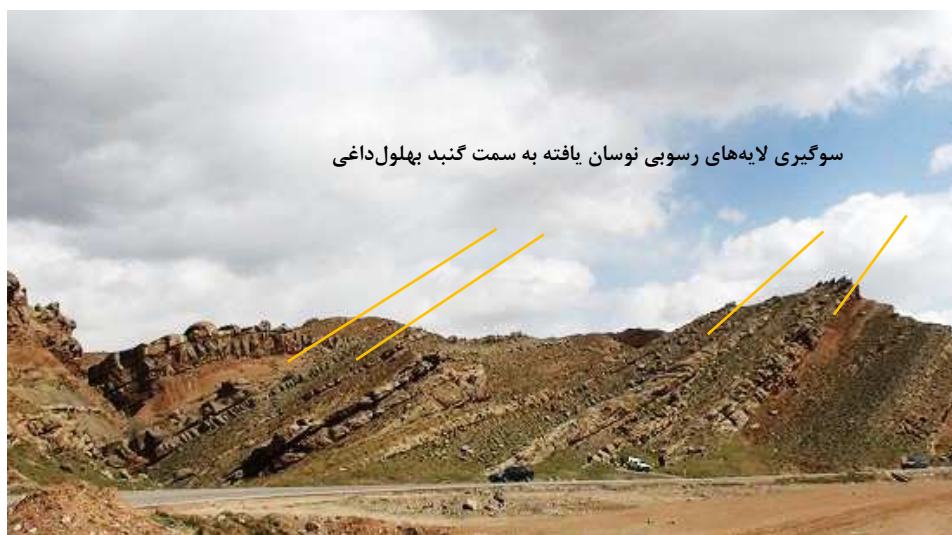
شکل ۹: باسکوله شدن لایه‌ها، تشدید فرسایش دیفرانسیل و وقوع گسیختگی‌ها و ریزش‌های ناشی از عملکرد گسل‌ها و خروج بهلول داغی در باختر این توده که همگی تهدید بالقوه برای بزرگراه درحال احداث تبریز-ارمنستان هستند.
