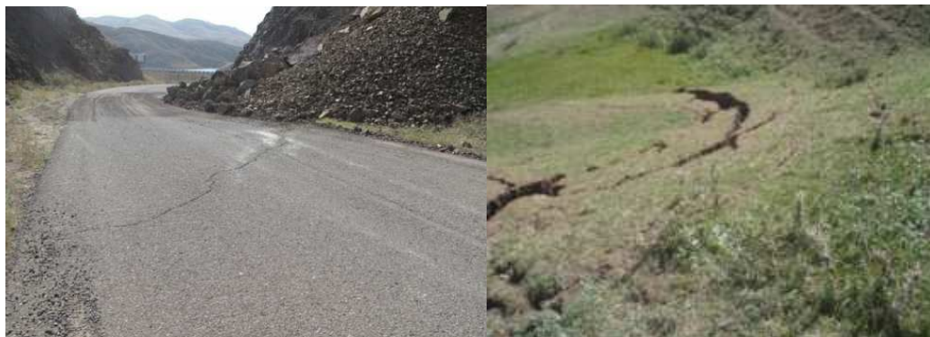
شکل ۵: لغزش بلوکی خاکی در ۳ کیلومتری شمال شرق روستای چوپانلار و سنگ لغزش در جاده سد ستارخان اهر
