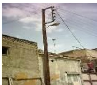
شکل ۱۴. عبور نامطلوب کابل های برق با توده های گیاهی و نصب لوله های گاز در جداره خارجی ساختمان ها بر دامنه خطرهای ناشی از آتش سوزی می افزاید ماخذ: نگارندگان
