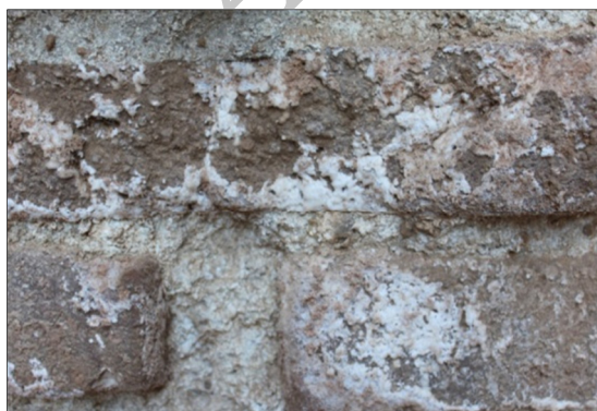
شکل ۴: سمت راست: نفوذ آب حاصل از بارندگی در ساختار دیوار و ظهور شوره‌های سولفات در سطح آجرکاری. ضلع شمال‌غربی معبد چغازنبیل. سمت چپ: تشکیل شوره‌های سولفات بر روی مواد و مصالح دیواره‌ی غربی آتشکده‌ی آذرگن‌سبب مجموعه‌ی جهانی تخت سلیمان (پیرک، پاییز ۱۳۹۱).
