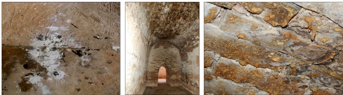
شکل ۱۶: تجمع فضله‌ی خفاش‌ها بر روی آجرهای طاق آرامگاه شماره ۵ مجموعه‌ی میراث جهانی چغازنبیل (پیرک، پاییز ۱۳۹۰) و لکه‌های حاصل از فضله‌ی پرندگان بر روی سنگ‌های ضلع جنوب شرقی آرامگاه کوروش، مجموعه‌ی میراث جهانی پاسارگاد (پیرک، زمستان ۱۳۸۳).
