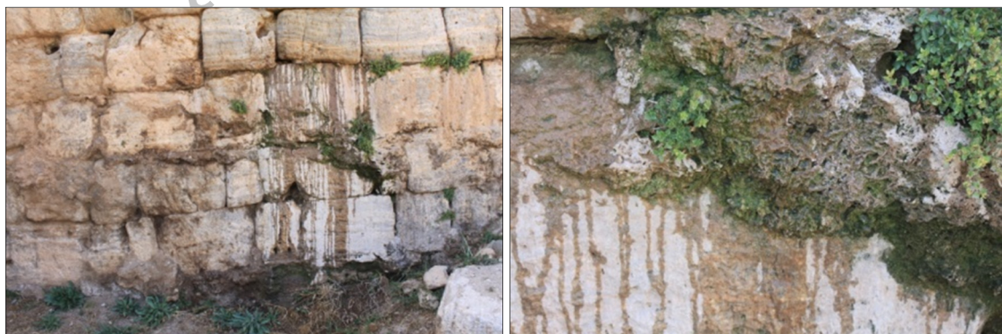
شکل ۸: نشت فاضلاب سرویس بهداشتی و تشکیل شوره‌های نیتراته بر روی سنگ‌های آهکی. باروی شماره‌ی ۲ مجموعه‌ی جهانی تخت سلیمان.
