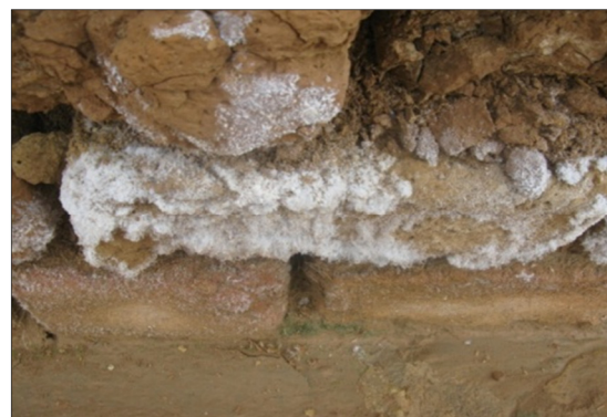
شکل ۴: سمت راست: نفوذ آب حاصل از بارندگی در ساختار دیوار و ظهور شوره‌های سولفات در سطح آجرکاری. ضلع شمال‌غربی معبد چغازنبیل. سمت چپ: تشکیل شوره‌های سولفات بر روی مواد و مصالح دیواره‌ی غربی آتشکده‌ی آذرگن‌سبب مجموعه‌ی جهانی تخت سلیمان (پیرک، پاییز ۱۳۹۱).
