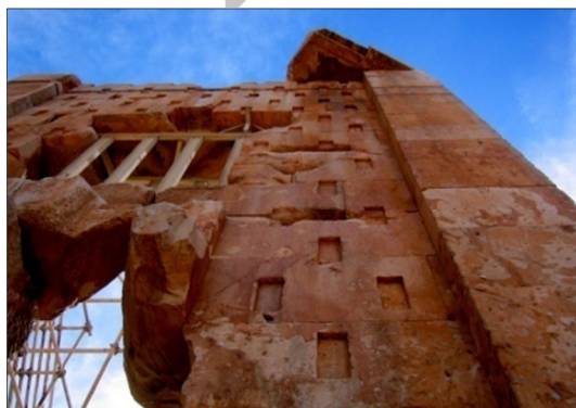
شکل ۱۴: تشکیل پاتین اگزالات با رنگ‌های مختلف بر روی سنگ‌های تراورتن. سمت راست: عمارت هشت‌ضلعی مجموعه‌ی میراث جهانی تخت سلیمان. سمت چپ: بنای موسوم به زندان سلیمان مجموعه‌ی میراث جهانی پاسارگاد (پیرک، پاییز ۱۳۸۹).
