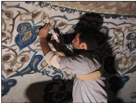
شکل ۶: تزریق ملات در فضاهای خالی بین لایه‌ها و استحکامبخشی لایه‌های آستر و بستر به روش میخ گچی Fig: 6: Injection of mortar in void spaces between layers and strengthening of fine coat and scratch coat Gypsum Nail method
