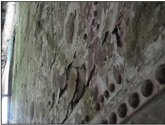
شکل ۳: فرسوده شدن و از بین رفتن بخش‌های زیادی از لایه آستر و شکستگی، ترک خوردگی و ریختگی بخش‌هایی از لایه بستر و ضعف اتصال آرایه‌های گچی قالبی به زمینه بستر
