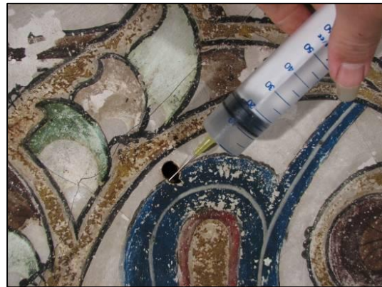
شکل ۵: تثبیت پشت و روی لایه بستر سقف گنبد بقعه سید رکن‌الدین Fig: 5: Stabilization of back and forth of fine coat in dome roof of Rokn al-Din mausoleum
