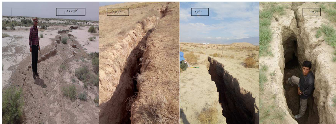
شکل ۲: تصاویر شکاف‌های حاصل از فرورانشست زمین در چهار منطقه مطالعاتی پژوهش
