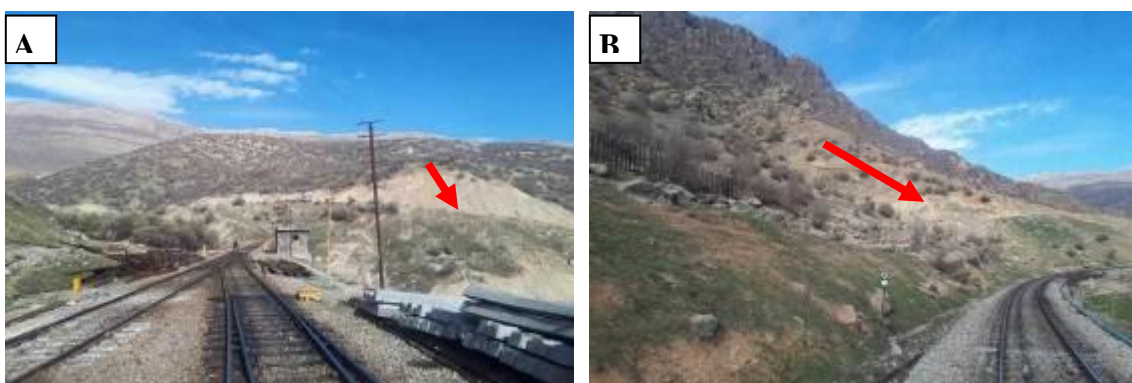
شکل ۹: A- نمونه ۱، ناپایداری قبل از ایستگاه بیشه کیلومتر ۰.۴۹۲، B- نمونه ۲ ناپایداری در کیلومتر ۳+۰۳۹۶ مابین ایستگاه های بیشه و سپید دشت
