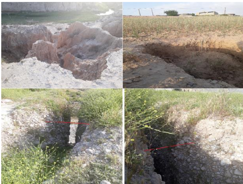
شکل ۱۳: ترک های شکل گرفته بخش شرقی مرکزی و جنوبی آبخوان
