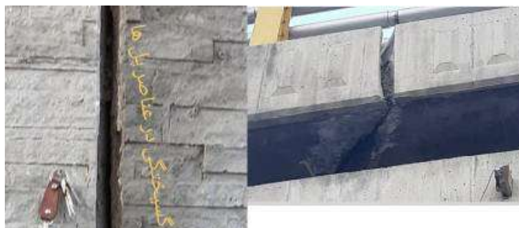
شکل - ۲۷: نمونه‌هایی از گسیختگی در عناصر پل‌های موجود در منطقه ۱۸ شهری تهران
