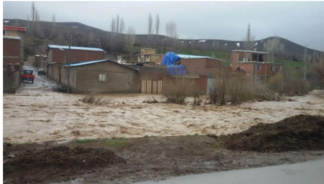
شکل ۱. مخاطره ژئومورفولوژیک ناشی از سیلاب در قسمت شمال رودخانه صوفی چای، روستای قشلاق
