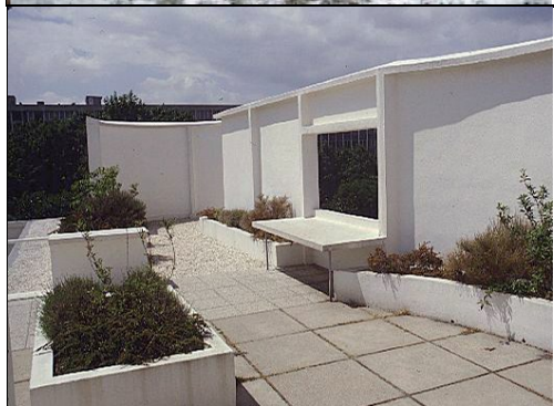
تصویر ۲- بام و نمای ساختمان ویلا ساووا
