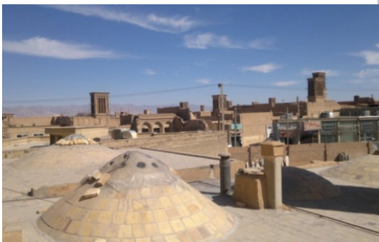
شکل ۱۱- سقف‌های گنبدی شکل
