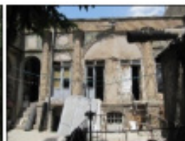
شکل ۱۹- خانه جارچی باشی Fig. 19- Jarchibashi's House
